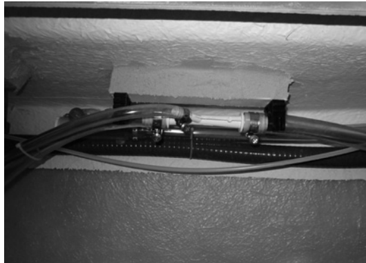
Abb. Ozoninjektor unter dem Poolrand des Whirlpools montiert
